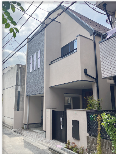
●現地写真 (令和6年 4月21日撮影)
